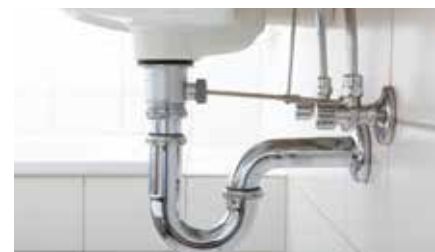
排水管 Water pipes
